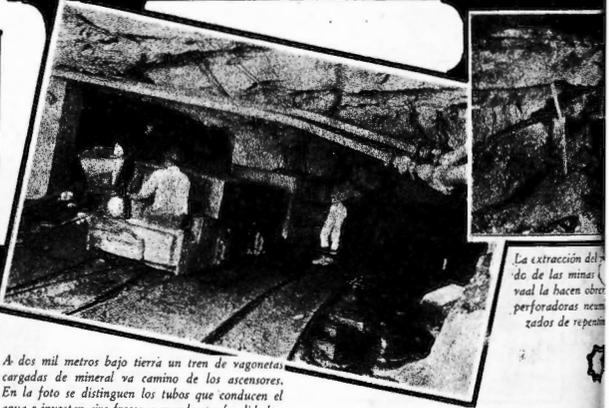
A dos mil metros bajo tierra un tren de vagones cargados de mineral va camino de los ascensores. En la foto se distinguen los tubos que conducen el agua e inyectan aire fresco a grandes profundidades.
